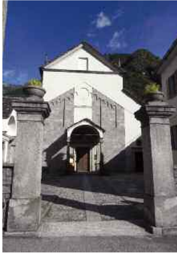
L'altissimo campanile di Montecrestese
